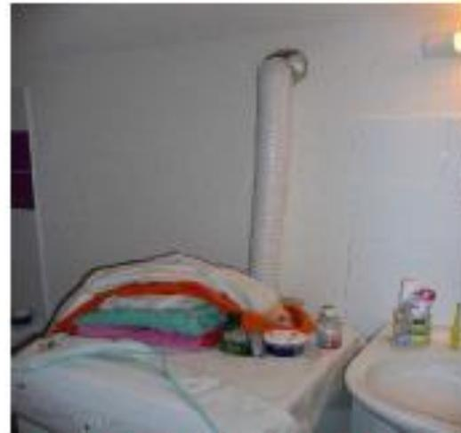
Raccordement interdit sur VMC
