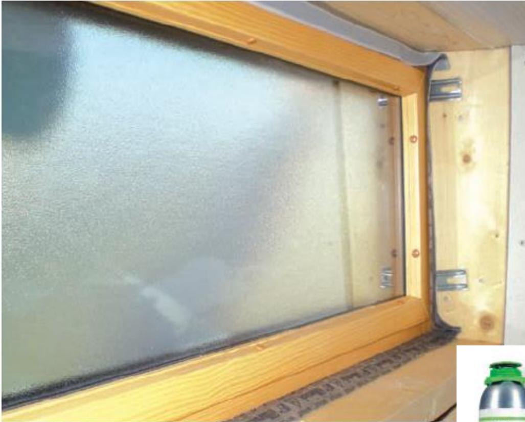
Membrane Duo en attente pour raccordement ultérieur au pare-vapeur intérieur
