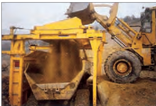
Chargement du crible.
