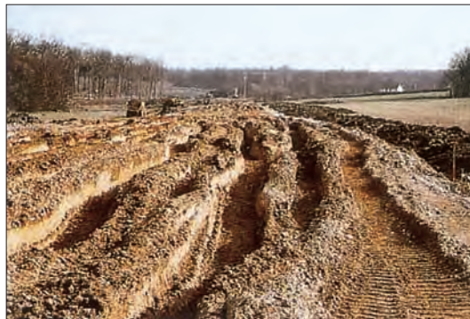
Comportement à la mise en remblai
