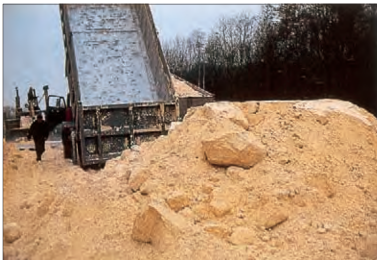
Un sous-produit industriel : le phosphogypse (classe F_5 ). Ce matériau se présente sous l'aspect d'un sable très frottant mais légèrement soluble.
