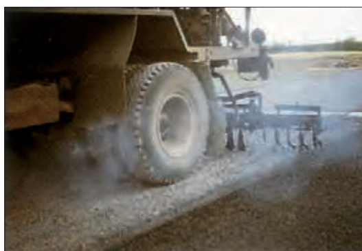
Répandage de l'émulsion.
