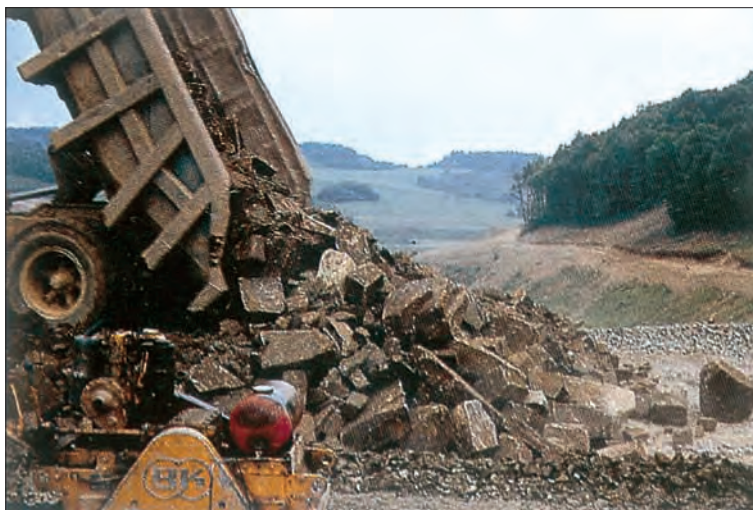
Roche magmatique dure (basalte) de classe R_{61}
