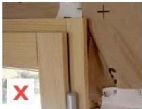
*Discordance du plan d'étanchéité à l'air au niveau de la jonction entre le châssis (dormant) et la membrane d'étanchéité à l'air.*
