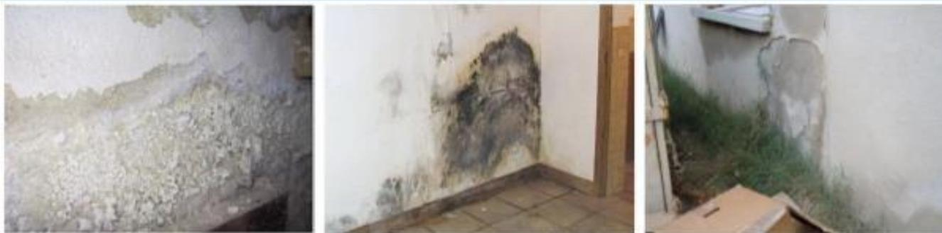
Pathologies observées après rénovation. De gauche à droite : présence de salpêtre (source : humidites.fr), présence de moisissures sur mur intérieur (source : prix-immobilier.info), trace d'humidité et enduit extérieur dégradé (source : Enertech).
