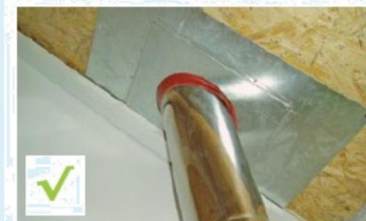
Coquille permettant de minimiser les fuites d'air autour du conduit d'évacuation des fumées et d'assurer une continuité de l'isolation.
