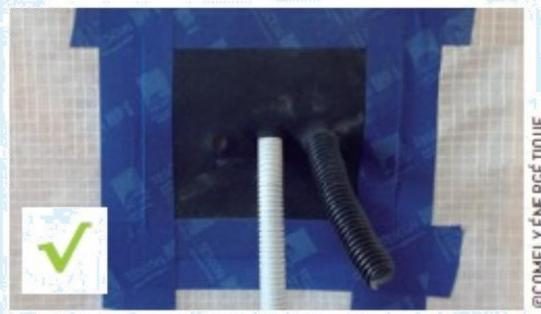
Passage des gaines une à une dans le plan d'étanchéité au travers de manchettes adaptées.
