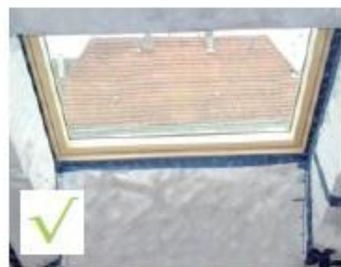
*Traitement complet de l'étanchéité entre le châssis de la menuiserie et le «tableau».*
