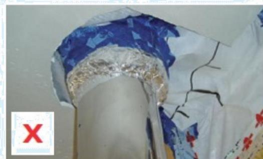
Défauts d'isolation et d'étanchéité à l'air autour des conduits d'évacuation des produits de combustion.
