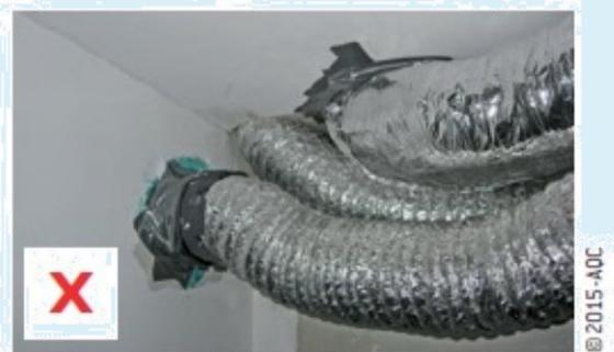
Défauts d'étanchéité à l'air autour des gaines de ventilation.
