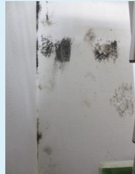
Apparition de moisissures à la suite de l'isolation de vieux murs. De gauche à droite : moisissures sur mur donnant sur l'extérieur, humidité dans les murs par suite de l'installation d'un voile étanche sous le plancher, traces de moisissures dans un mur de refend (sources : AQC).
