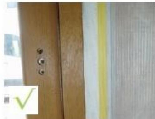
*Continuité de l'étanchéité à l'air assurée avec l'utilisation d'un adhésif adapté.*
