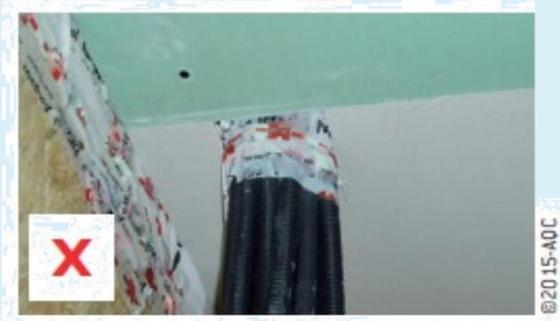
Gaines électriques passant en paquet au travers du plan d'étanchéité à l'air. Utilisation de manchettes impossible.
