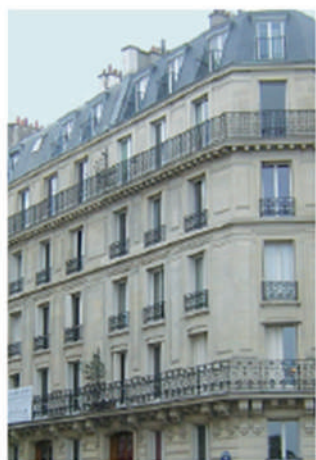
Immeuble de type haussmannien
