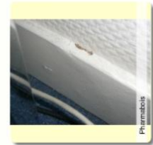
Dégâts sur plinthes avant sondage
