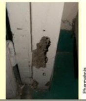
Dégradations caractéristiques de termites souterrains sur bâti de porte
