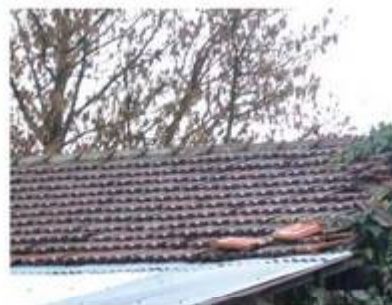
tuiles à remplacer
