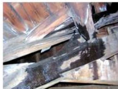
infiltration en toiture
