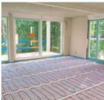
**Plancher chauffant électrique** : Constitué d'un réseau de câbles chauffants basse température (28°C max pour la température du sol) coulé dans la chape liquide de la pièce. La chaleur, qui vient du sol, parfaitement répartie dans la pièce. L'effet "pied froid" est supprimé.
