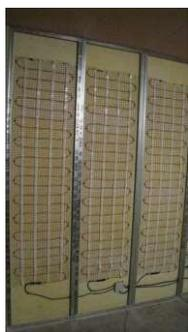
**Mur chauffant électrique** : Les films radiatifs basse tension de grandes dimensions sont appliqués directement sur les murs et recouverts d'un simple crépi ou d'une plaque de plâtre.
