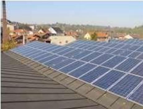
**Capteurs photovoltaïques**: modules solaires composés de cellules à base de silicium qui produisent de l'électricité (volts) en courant continu à partir de la lumière du soleil (photons)
