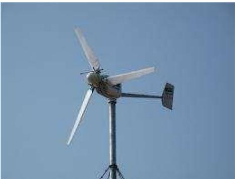
**Micro éolien** : fait partie de la famille **du petit éolien**, également nommée la famille des éoliennes domestiques ou des éoliennes pour particulier. Celle-ci se distingue par trois éléments principaux que sont le nombre de ses pales, sa dimension, et son fonctionnement. Sa puissance maximale se situe aux environs des 200 watts.
