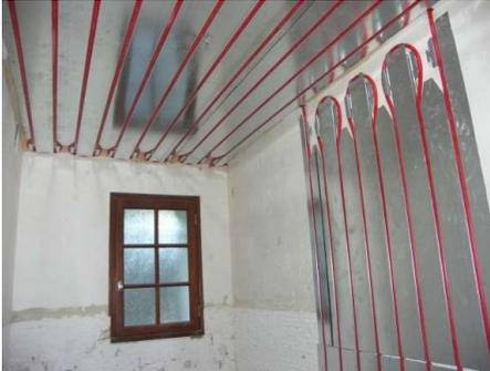
**Plafond chauffant hydraulique rayonnant** : Il existe différents systèmes, intégrés ou en applique, suivant les types de plafond et les applications :
