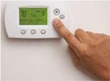
**Thermostat d'ambiance** : Régulation centralisée qui pilote le chauffage du bâtiment ou de la zone et permet de maintenir la température ambiante à une valeur choisie.
