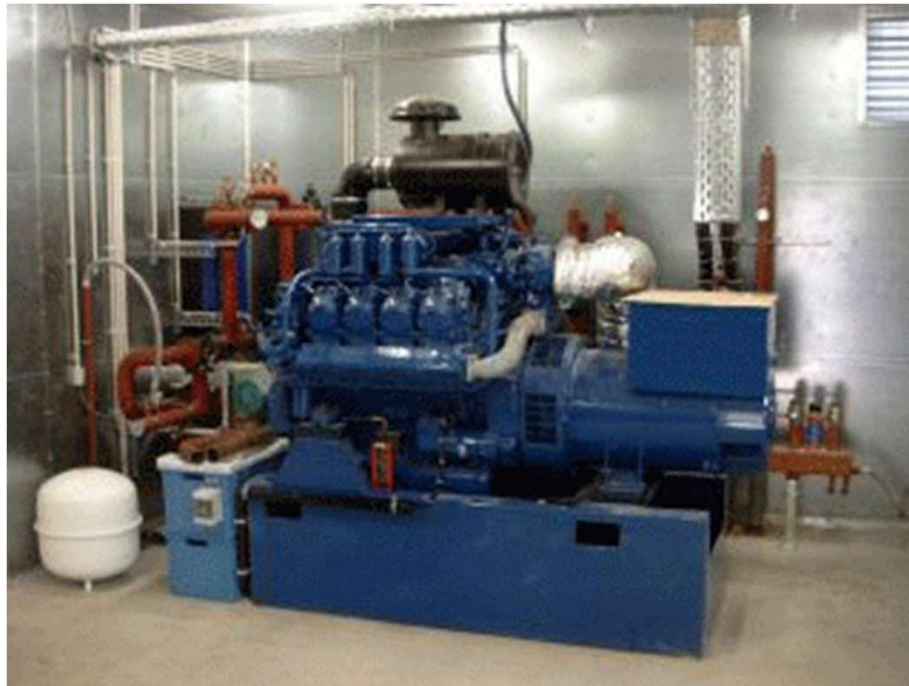
Centrale locale de cogénération de Masnedo (Danemark), produisant de l'électricité et de la chaleur pour un réseau local, à partir de paille
