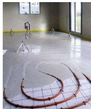
Fixation par clips chape fluide
