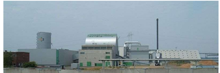
Centrale locale de cogénération de Masnedo (Danemark), produisant de l'électricité et de la chaleur pour un réseau local, à partir de paille
