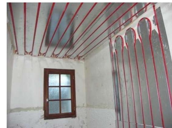
Sous plaque de plâtre ou de gypse
