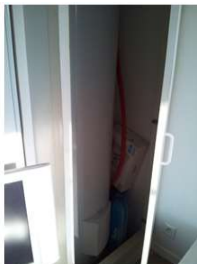
Ballon ECS en volume chauffé
