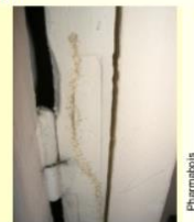
Pigmentation résiduelle sur montant de porte après grattage d'une galerie-tunnel
