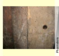
Trous de petites vrillettes sur montant et injecteur de traitement
