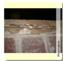
Aspect feuilleté d'un raidisseur de cloisons
