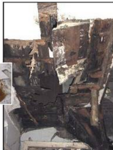
Plancher dégradé par les mérules
