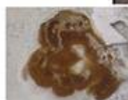
Fructification de mérule sur un mur
