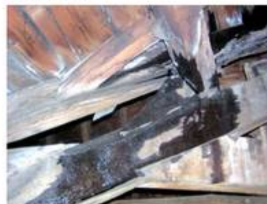
infiltration en toiture
