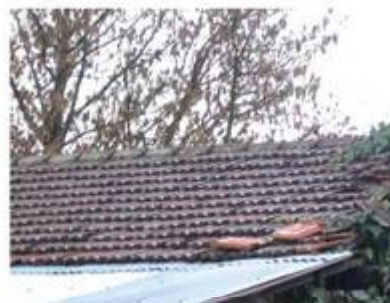
tuiles à remplacer
