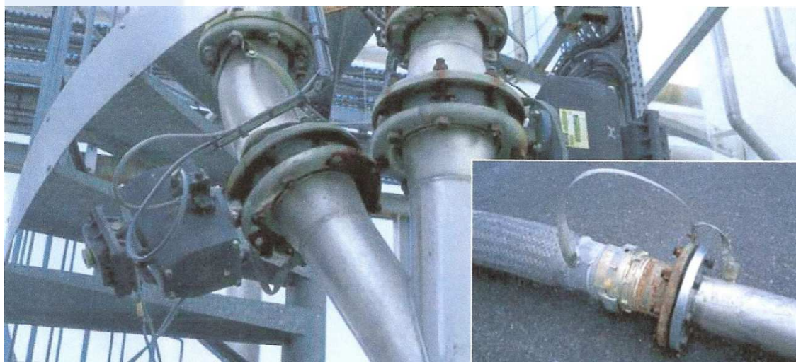
Figure 3.4 Illustration de la nécessité de mise à la terre (a) Risque de décharge entre la cuve et l'opérateur (b) La mise à la terre supprime le risque de décharge
