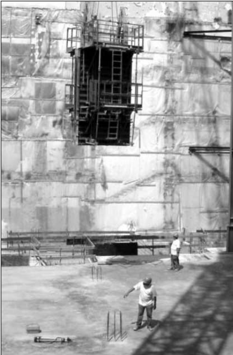
UNE BANCHE portée par la grue au-dessus du chantier.
