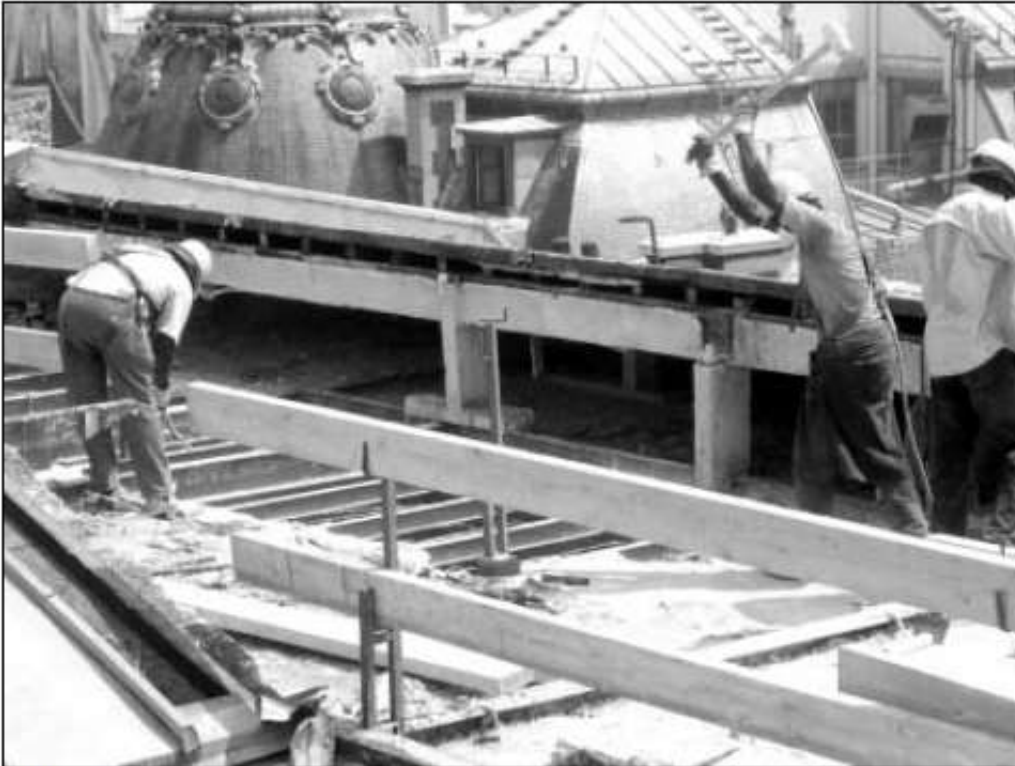
LA DEMOLITION est la partie la plus dangereuse d'un chantier.
