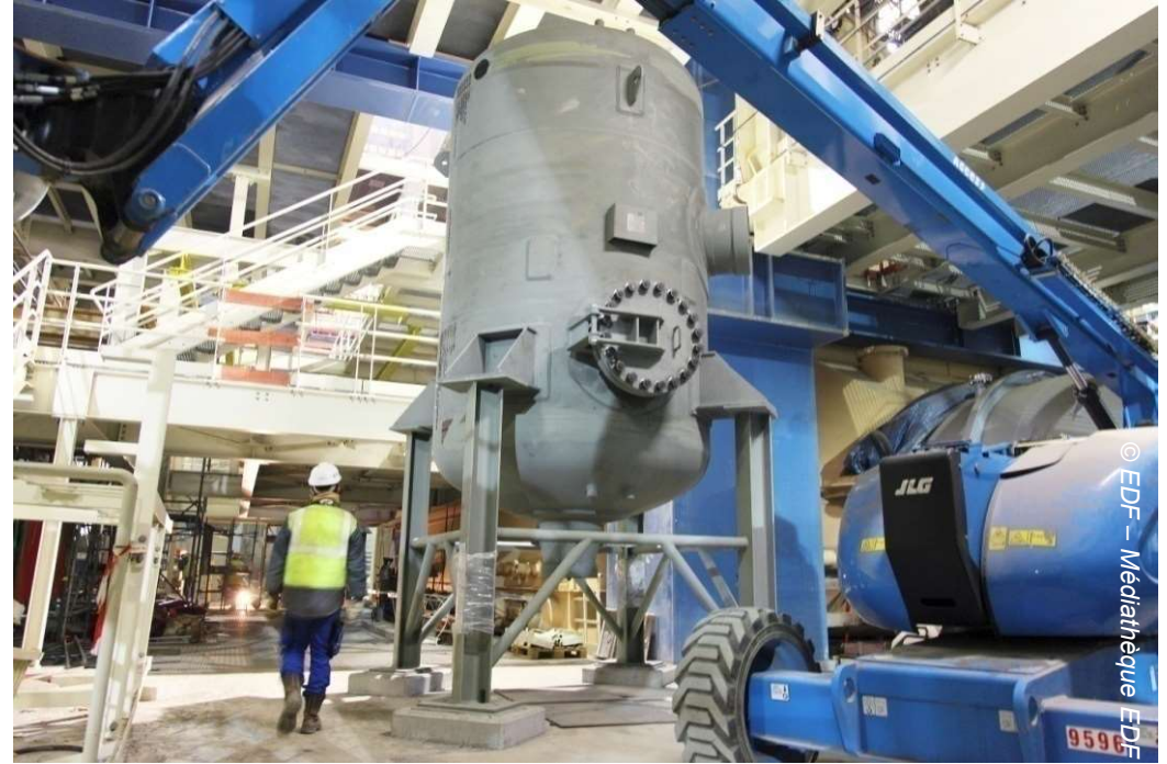
Réservoir de recueil des purges des sécheurs surchauffeurs - 2010
