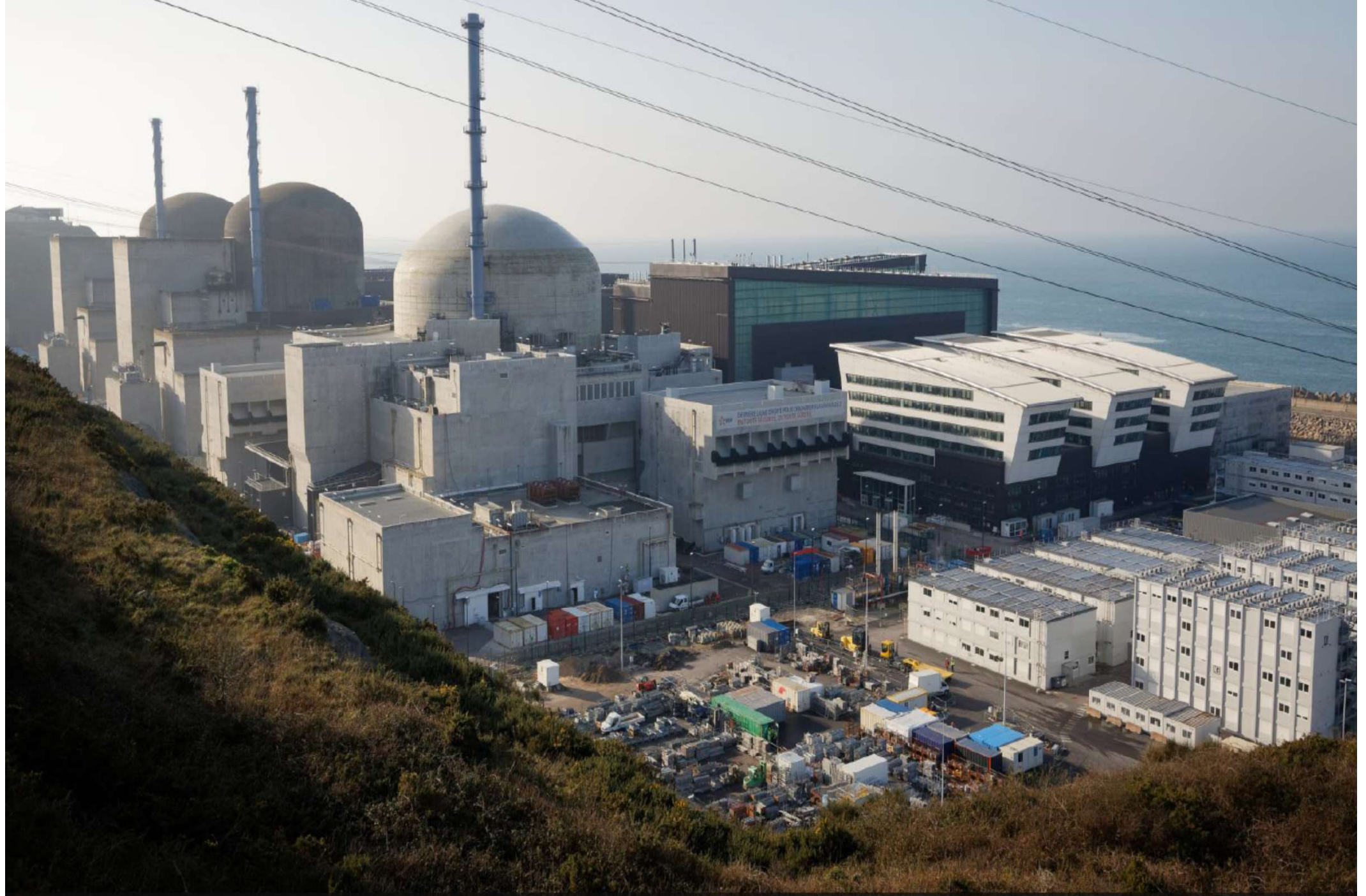
Le chantier EPR Flamanville 3 – janvier 2020
