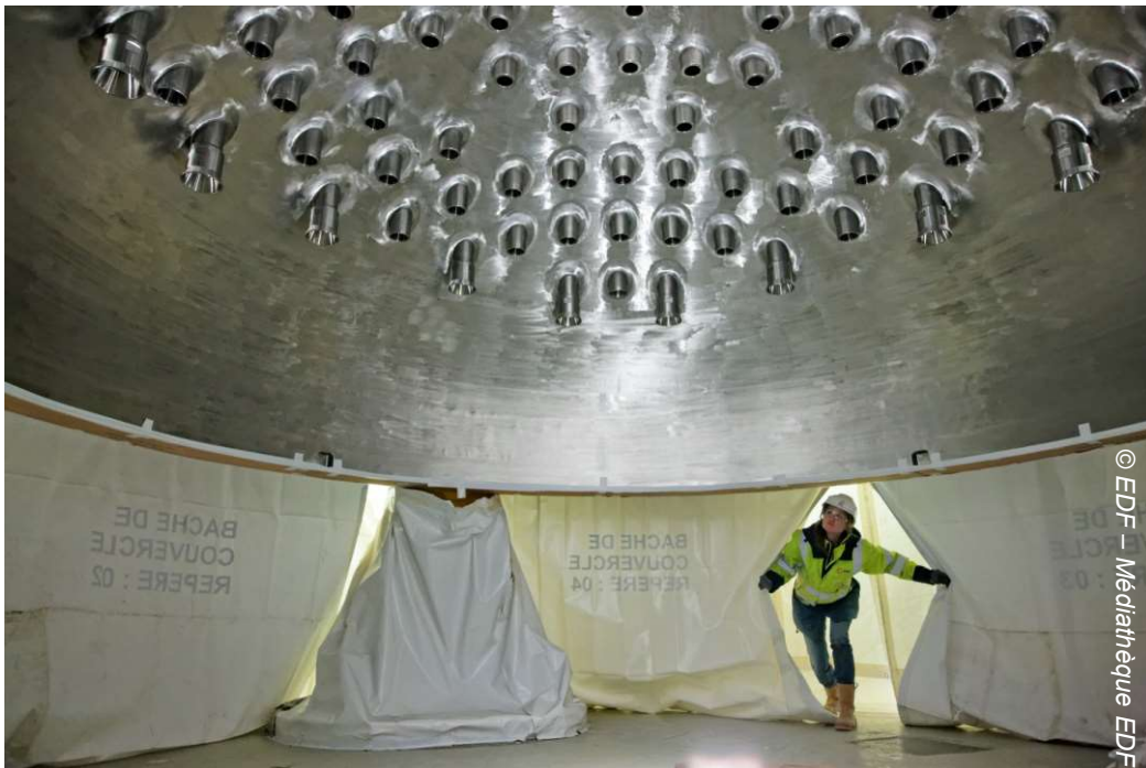
Dessous du couvercle de cuve (non équipé) - 2016
