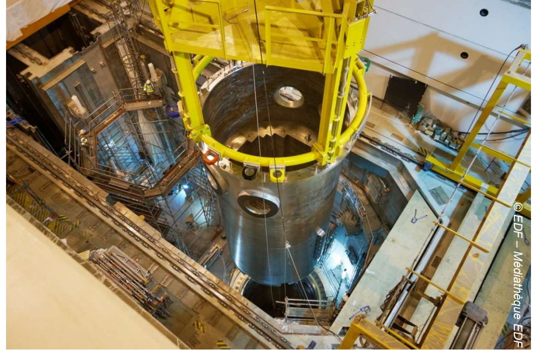
Installation des internes dans la cuve du réacteur - 2016
