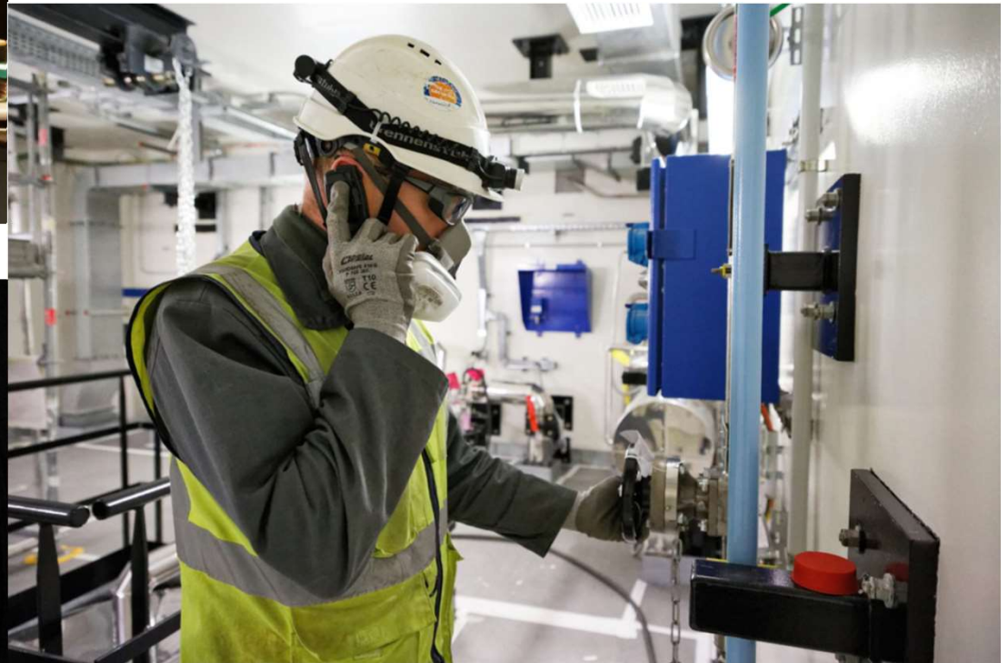
Bâtiment de traitement des effluents Rinçage sur ligne en eau du système des effluents liquides usés avant la réalisation d'essais.
