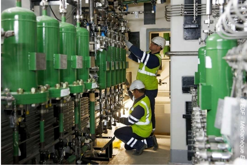
Raccordement des lignes d'échantillonnage nucléaire - 2015
