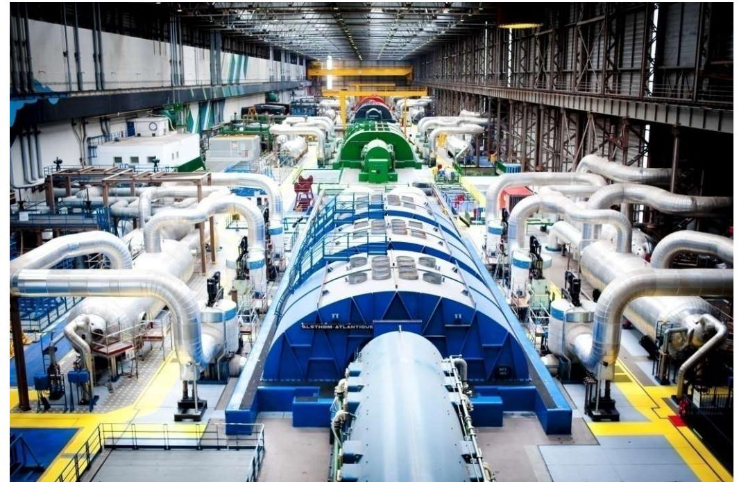
Salle des machines, groupes turbo-alternateur et sécheur surchauffeur – Tricastin
