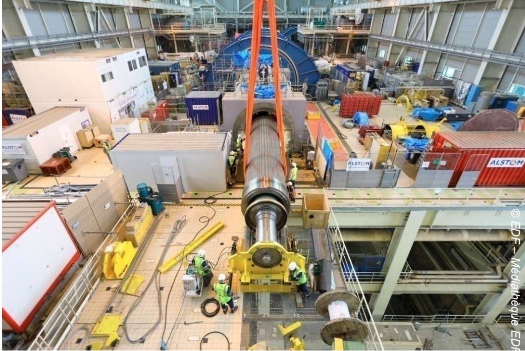
Mise en place du rotor dans le stator de l'alternateur - 2012
