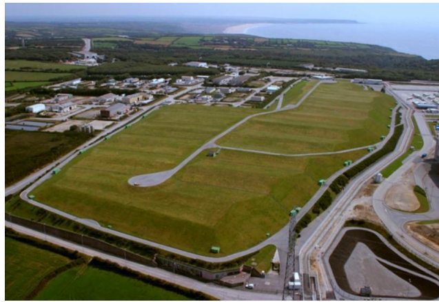
Figure 4 : Site du CSM avec sa couverture végétale [9]
