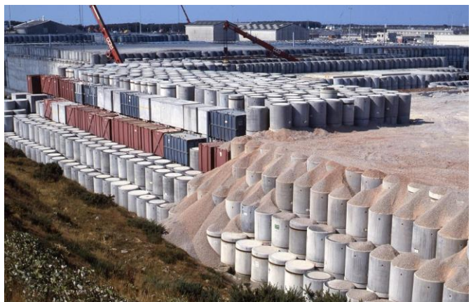
Figure 3 : Stockage des déchets au CSM avant la couverture [7]
