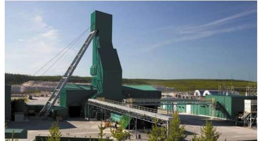
Figure 3 : Chevalement principal de la mine de McArthur River qui couvre le treuil au-dessus du puits vertical. Source : CNSC.
