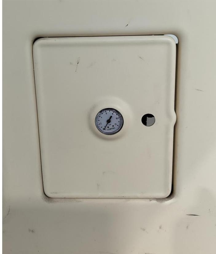
Et ouvrez la vanne d'air comprimé, puis vérifiez sur le manomètre que la valeur soit de 4 bars.
