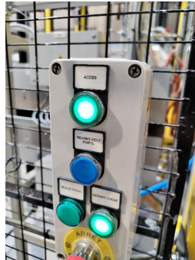
Porte de gauche déverrouillée
